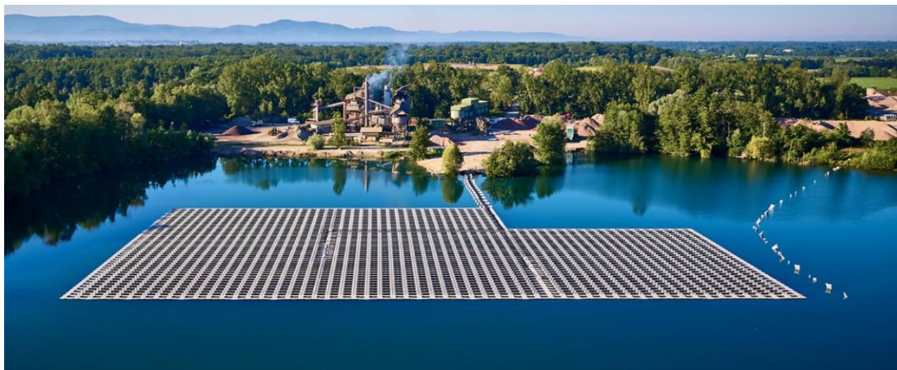
Рисунок 1 - Плавуча фотоелектрична електростанція потужністю 750 кВт поблизу Ренхена в Бадені, Німеччина
